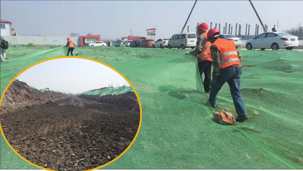
洮河路西延项目施工现场,工人正在铺设防尘网。
