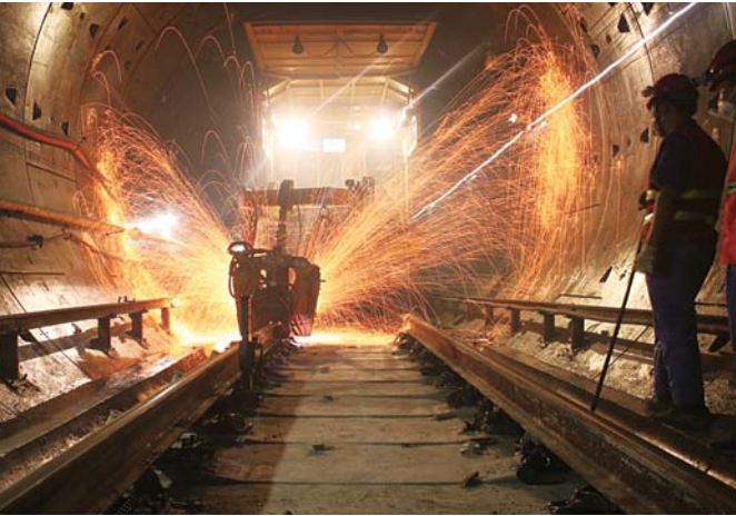
地铁3号线区间无缝钢轨焊接。
