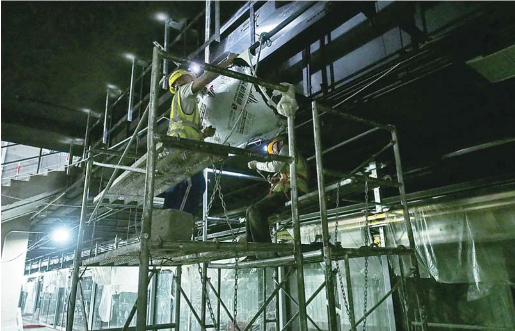
济南地铁3号线工业北路站内工人正在进行铝板安装。
