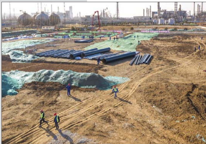
兖矿鲁南化工己内酰胺项目复工建设。
