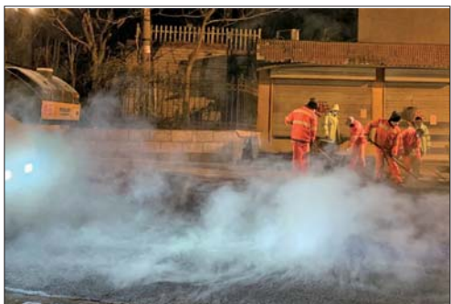
3月4日深夜,济南千佛山东路,工人们正在整修路面,城市逐渐恢复了活力。刘国林 摄
