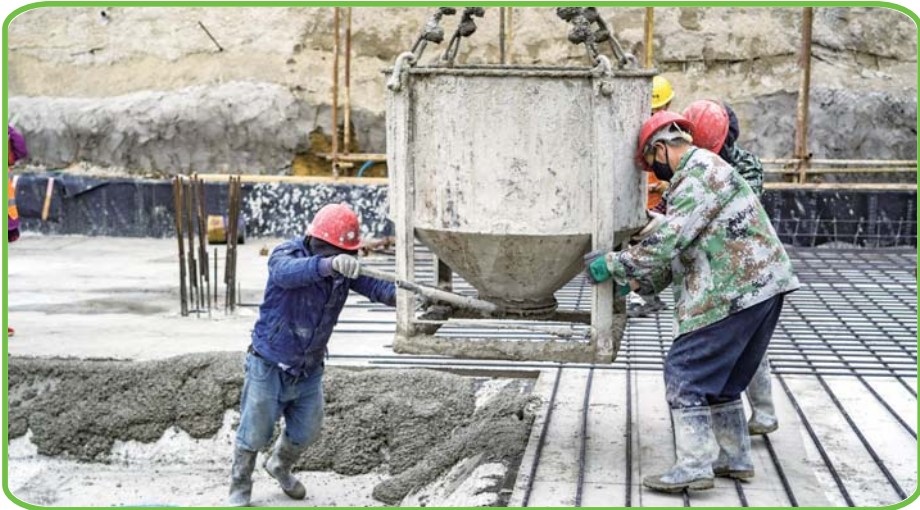
施工人员正在浇筑混凝土。
