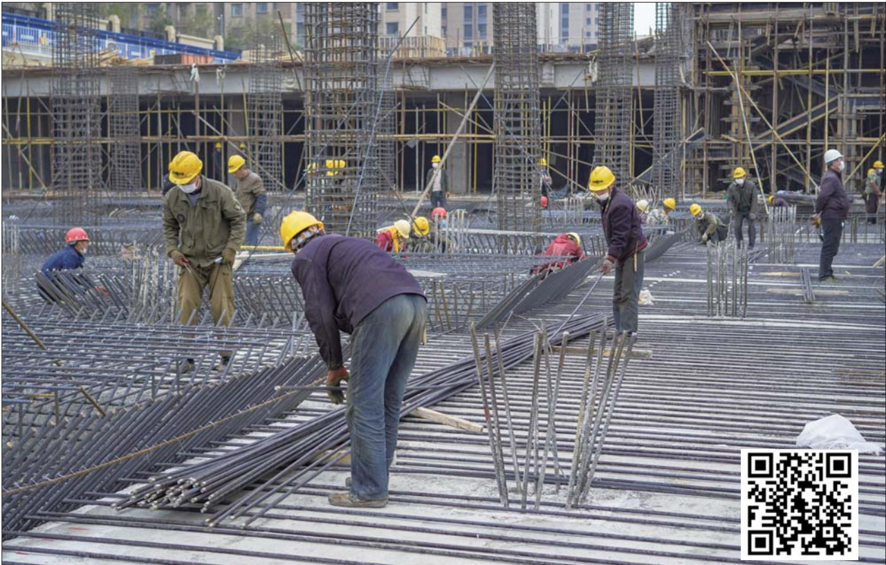
施工人员正在钢筋绑扎作业。
