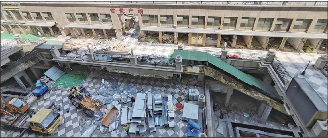
诚基中心三期末商正在拆除。 齐鲁晚报·齐鲁壹点记者 戚云雷 摄
