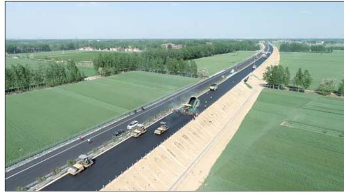
施工,包括路面施工、交安、绿化工程。目前路基桥涵工程已全部完成,路面工程完成约90%,交安、绿化工程完成约80%。
