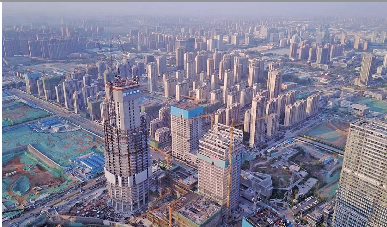
占地26.3平方公里的济南国际金融中心正拔地而起,气势雄伟。齐鲁晚报·齐鲁壹点记者 周青先 摄
