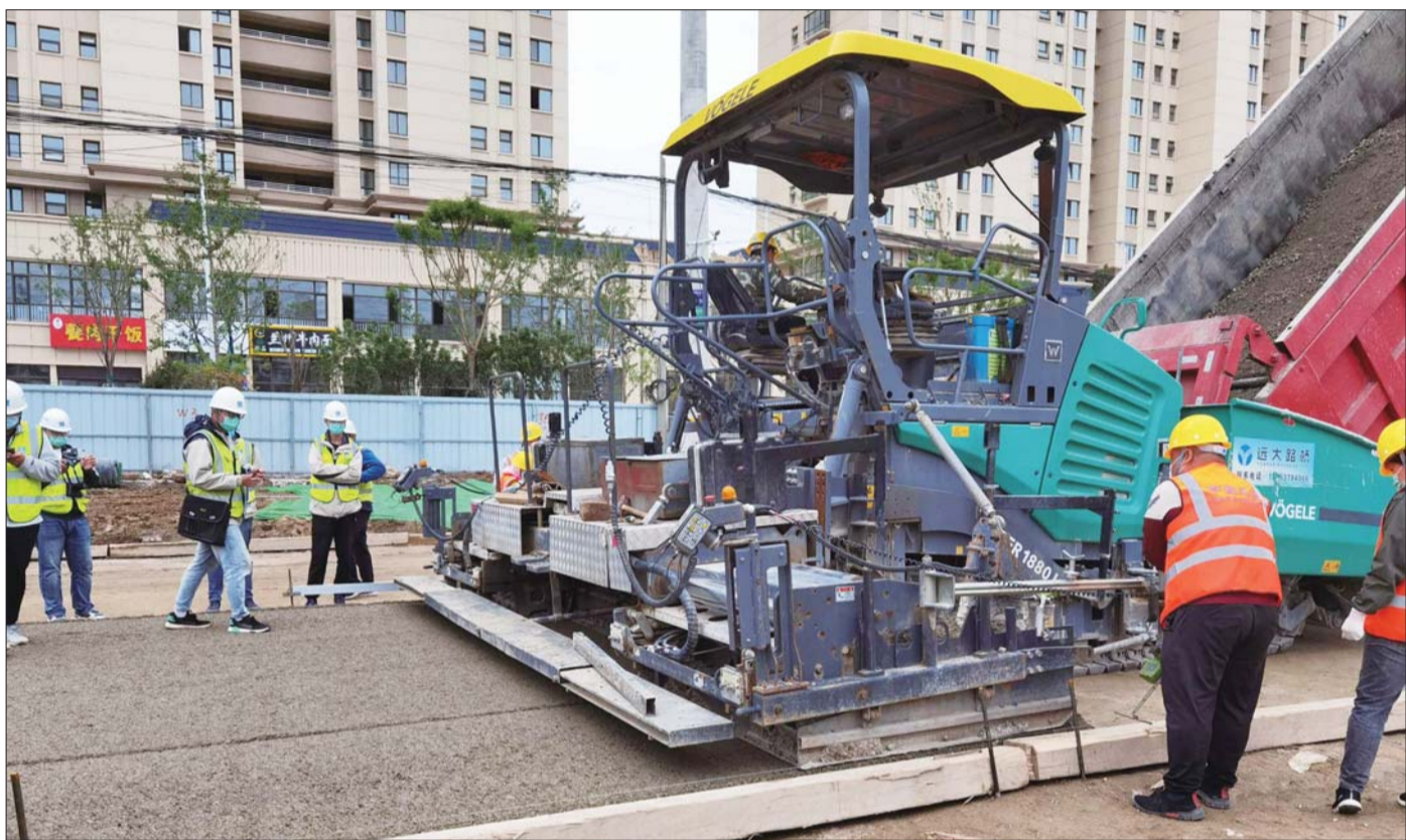
车站西路升级改造项目开始摊铺水泥稳定碎石基层。
