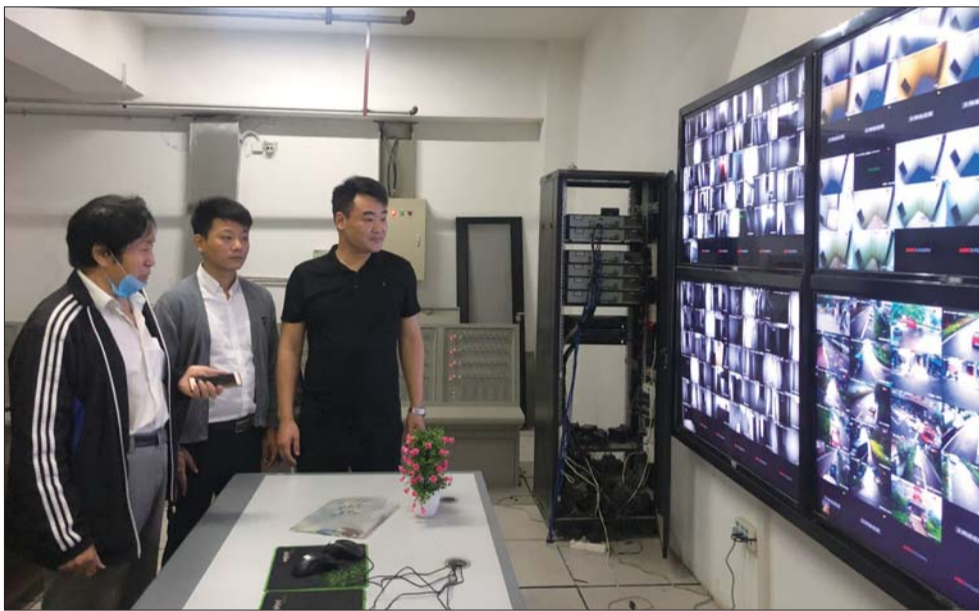
许庄街道安全生产办公室工作人员在京杭佳苑社区检查消防隐患。
