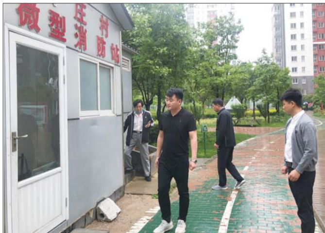
京杭佳苑社区白庄村微型消防站。
