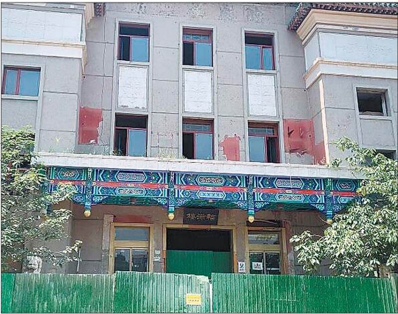
►明星电影院老建筑内部正在施工修缮。
