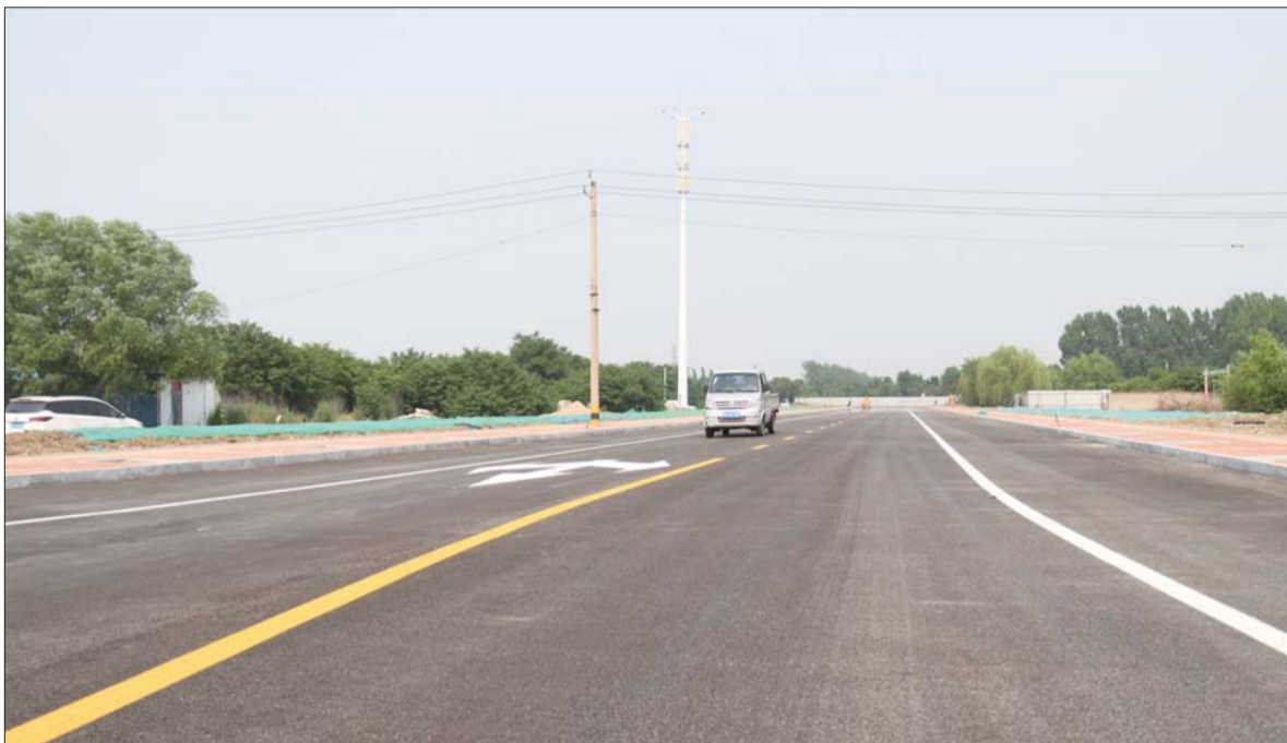
直达火炬路的农场路东延工程。
