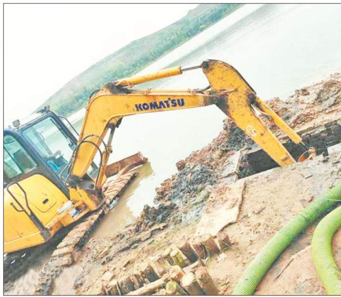
工作人员正在用挖掘机清理雨水口处的大量淤泥。
