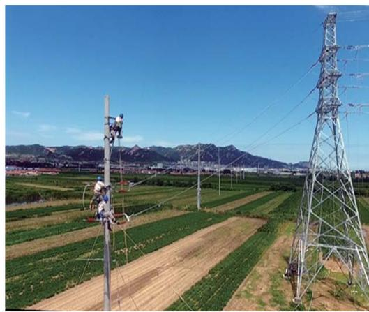
供电公司在全省公司支持下,在为朱口站增上第二电源35千伏玄朱线的同时,全面启动35千伏朱口线升级改造工程。改造工程共需新建钢管塔5基,角钢塔9基,18米水泥杆1基,架设双回路导线长度共18260米。
