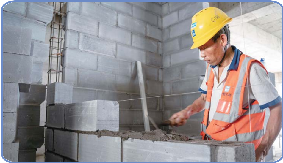
工人正在砌筑墙体。
