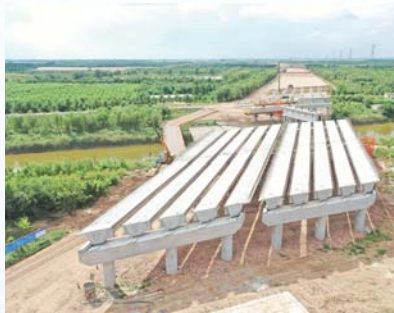
三号支沟大桥两跨预制箱梁架设完成
