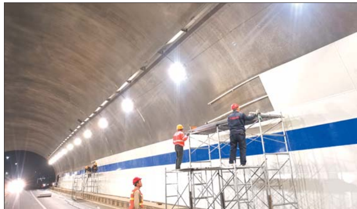
施工现场。通讯员供图
