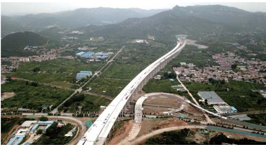
公里,途经济南市中区兴隆街道、南部山区锦绣川街道、柳埠镇,设置长城岭隧道与泰安段相接,全线采用双向六车道标准,设计行车速度120公里/时。济南段主线设隧道5座,主线桥梁20座,桥隧比高达约68%。
