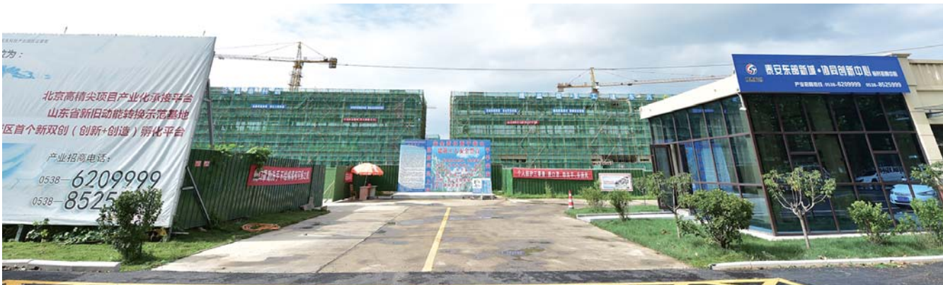
省庄镇养心谷一期项目建设
