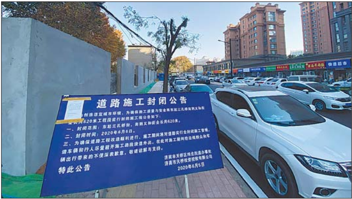
小区旁道路施工的通告。路修完了,业主还是没处停车。
