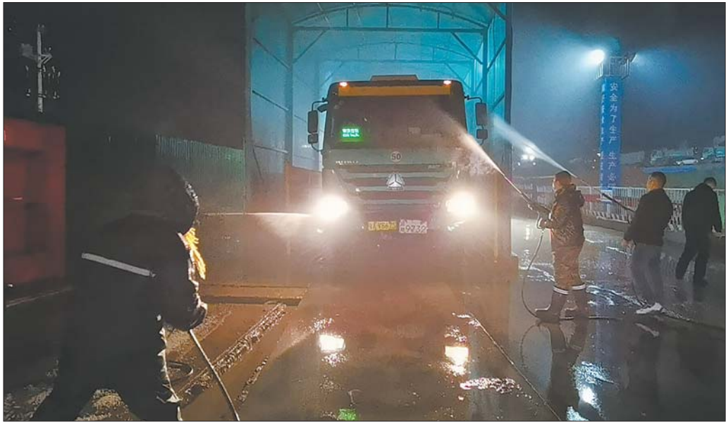
开元寺生态景观提升工程门口设有冲洗设备,渣土车驶出工地要“洗澡”。
