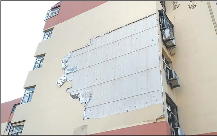
外墙保温层大面积脱落。
