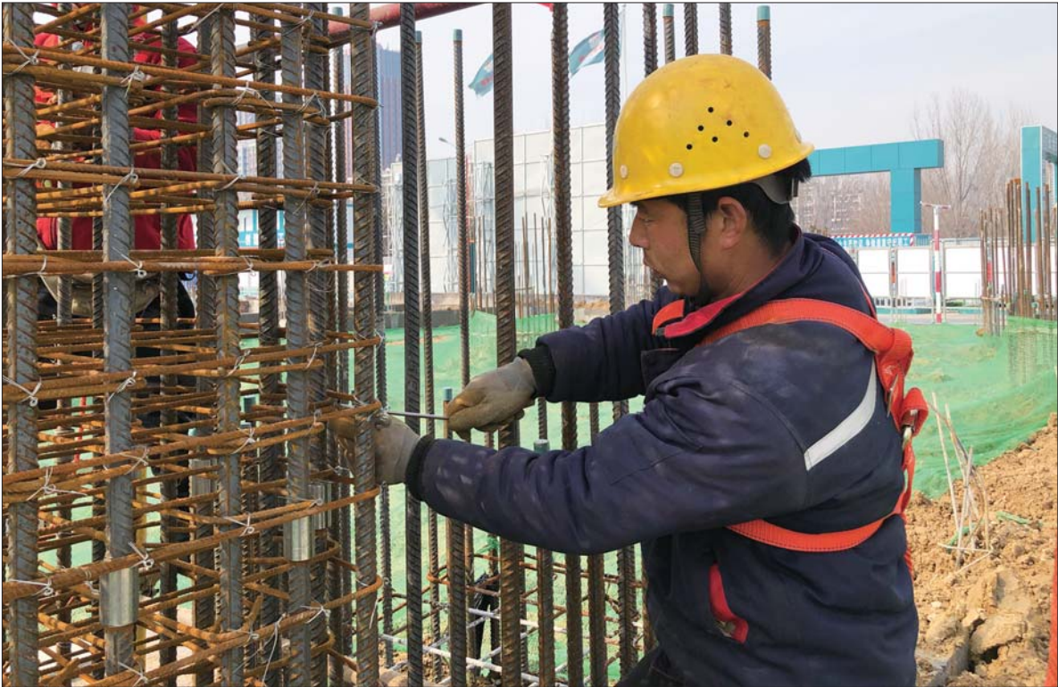
安全帽、安全绳是施工安全的必要保障。
