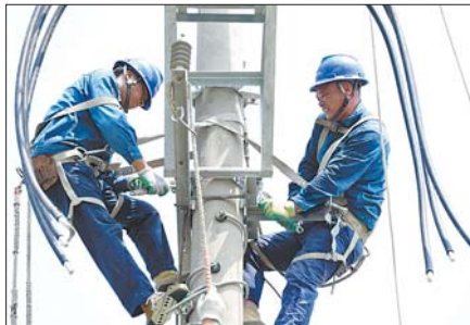
威海供电公司服务队队员在进行电力作业。
