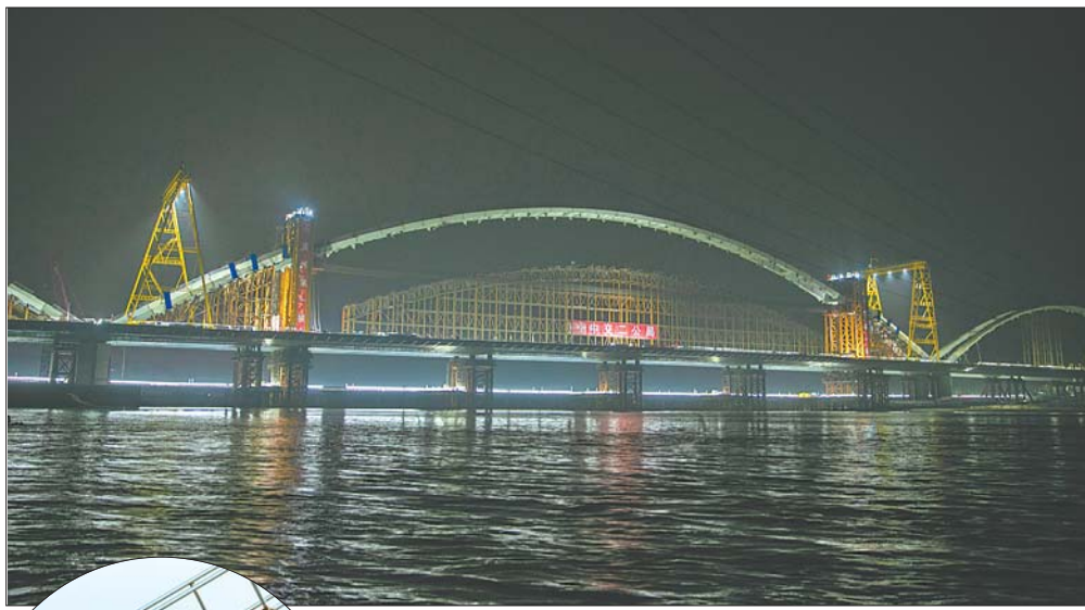
3月15日上午11时许,齐鲁黄河大桥主拱拱肋完成提升。
