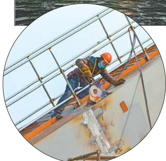
工人在进行合龙施工。
