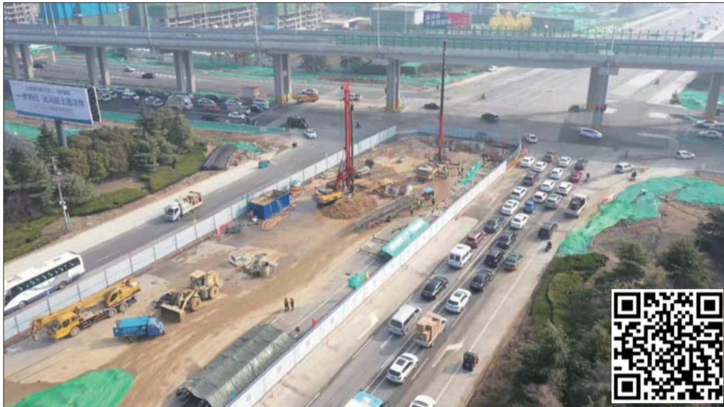
崇文大道跨宁安大道跨线桥项目,节后工程进展迅速。
