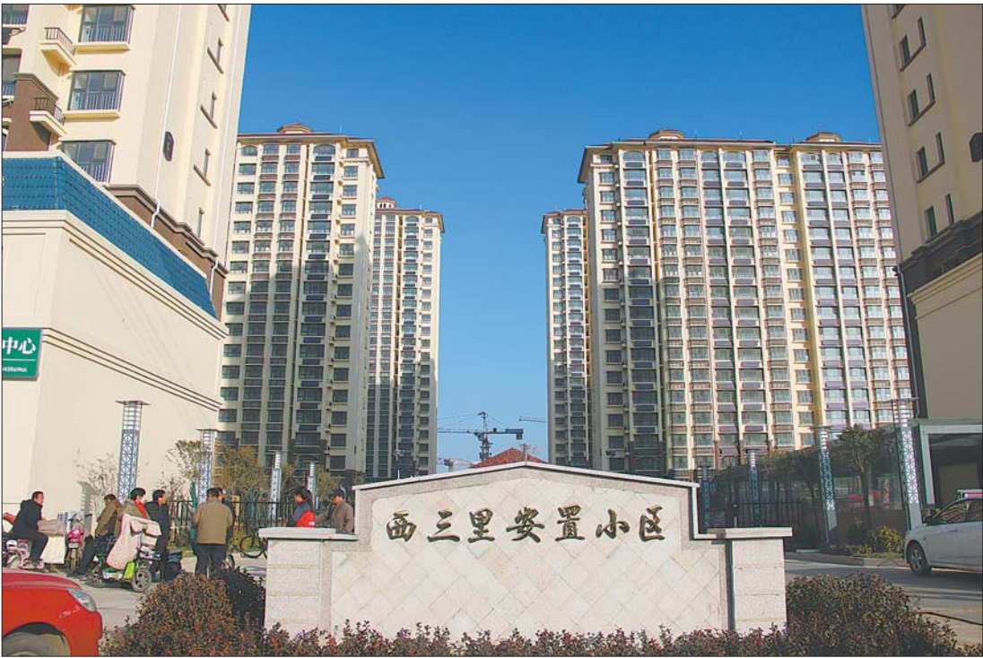
西三里安置小区
