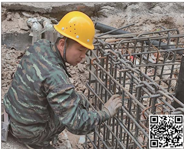
工作人员进行钢筋绑扎。齐鲁晚报·齐鲁壹点记者 周惠娇 摄 扫码看视频。
