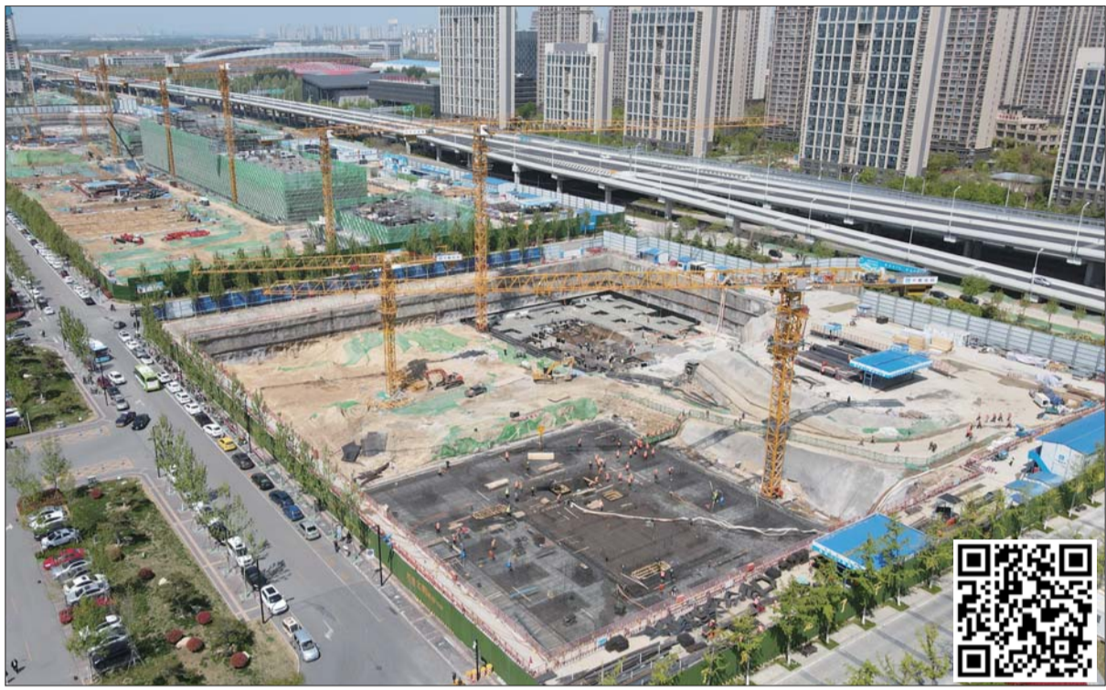
政务中心已进入地上4层主体施工。
