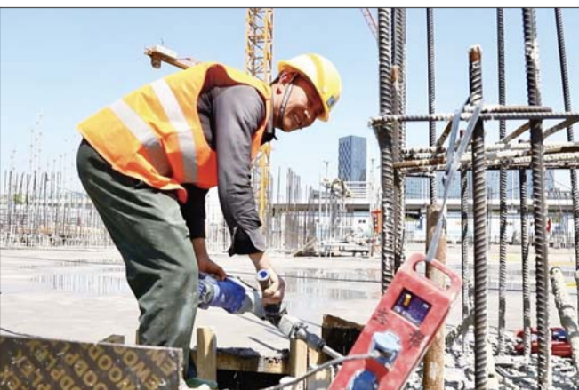
工人正在支设模版。
