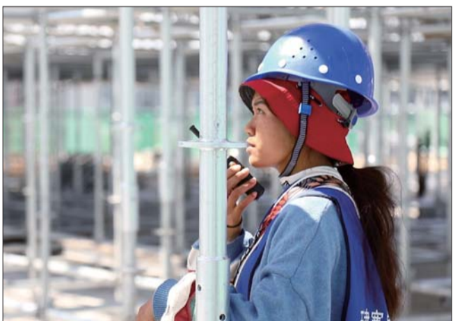
项目现场工人达800多名。
