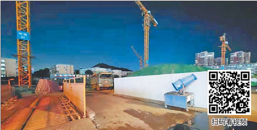
姚家小学项目工地上已经按下“静音键”。
