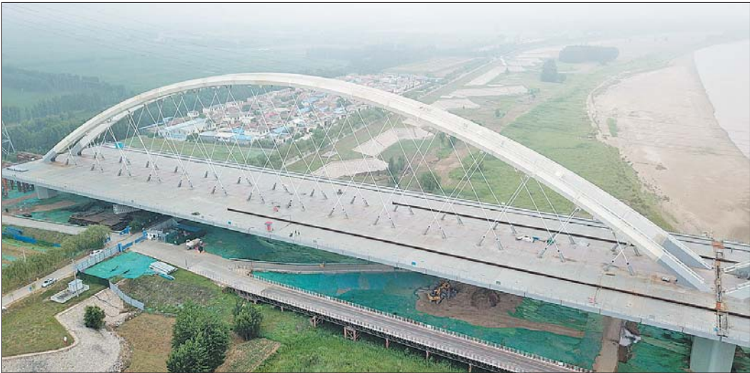
齐鲁黄河大桥正在进行主跨吊索施工。
