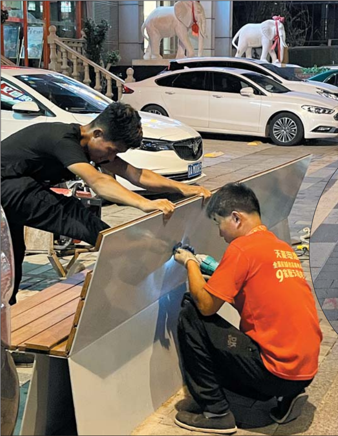
▲覆盖高耐竹材前的座椅。 ▲工作人员正在给钢板座椅安装高耐竹材。
