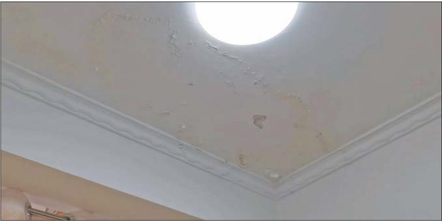
业主刘女士的房子渗水,致使屋顶墙面起皮脱落。
