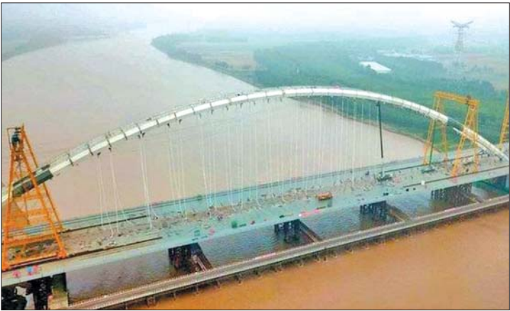
齐鲁黄河大桥三拱200根吊索全部安装完毕。
