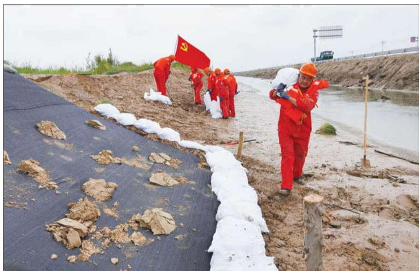
输电运维工作站员工紧急处理因雨水冲刷造成的安全隐患。
