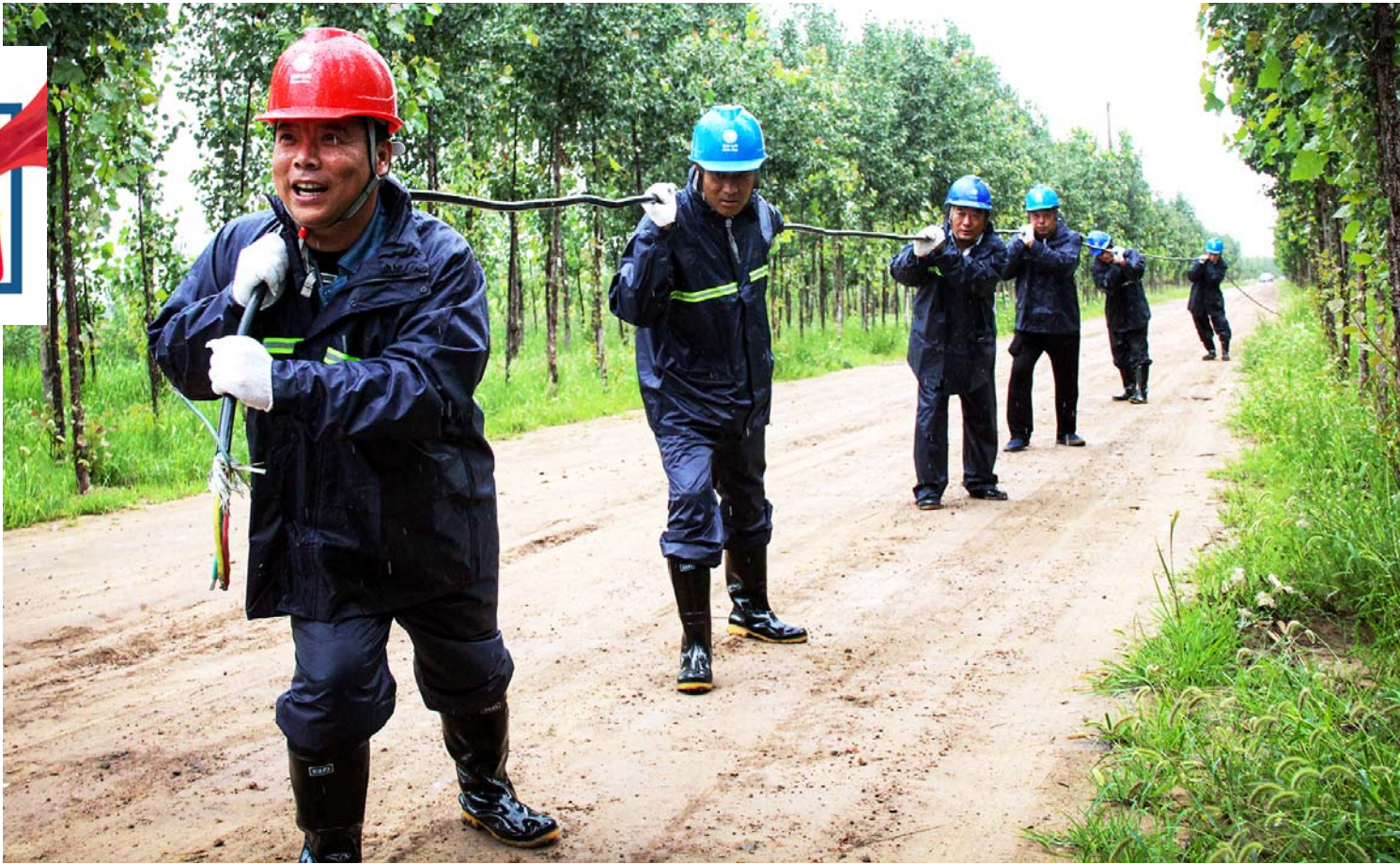
▲7月27日,乐陵供电公司胡家供电人员在漳卫新河河堤开展电缆敷设施工,提前做好“莲花弯”段行洪防汛指挥部临时电源接装工作。(高有联)
