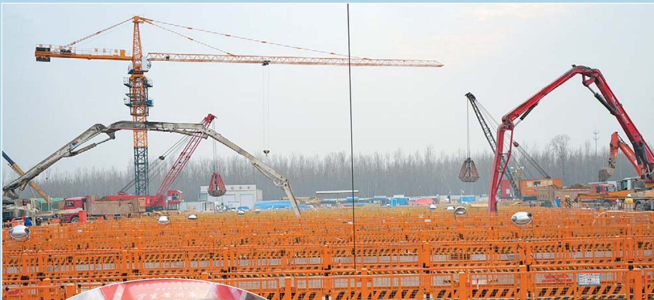
2018年12月20日,济南黄河隧道工程首段底板顺利浇筑。
