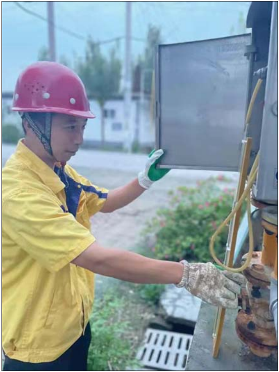
为保障用户用气安全，赵龙正在进行燃气调压箱日常维护。
