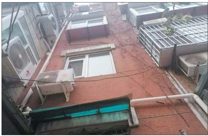
装上下水管,楼上空调就不会往院里滴水了。
