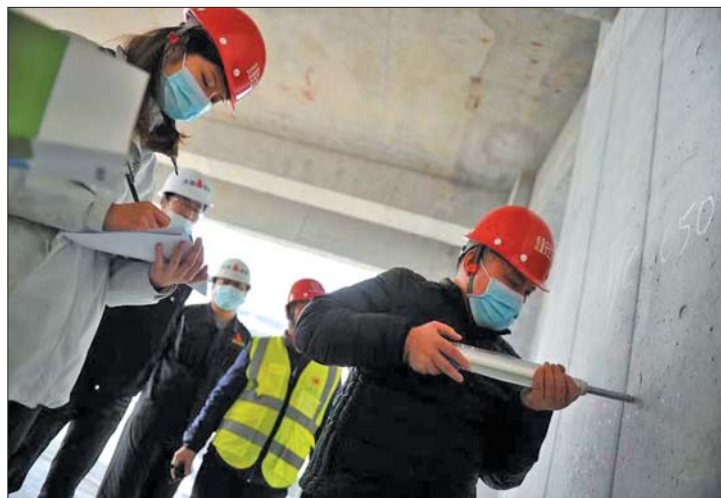
强化预拌混凝土质量管控,确保工程主体结构质量安全。
