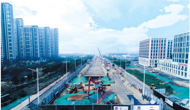
轨道交通4号线一期工程火热建设如火如荼。
