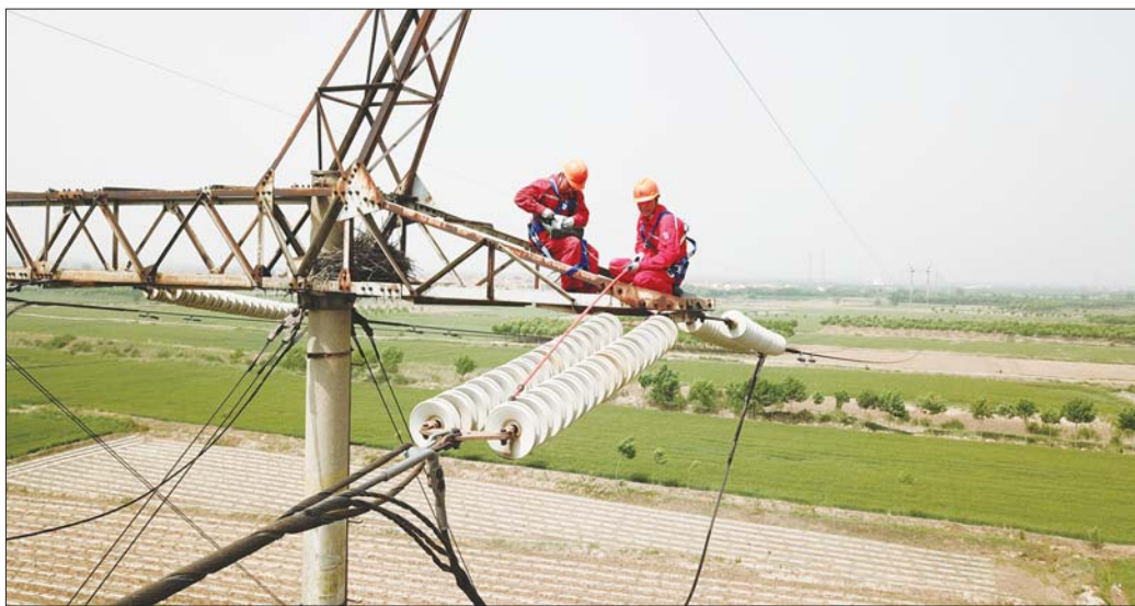
胜利电力员工对220千伏九孤线进行检修,确保油田电网安全平稳运行。 通讯员 颜曾 荆玲 摄
