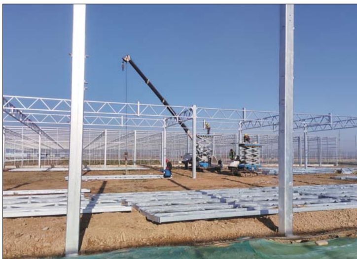
正在建设中的梁山县现代农业产业园。
