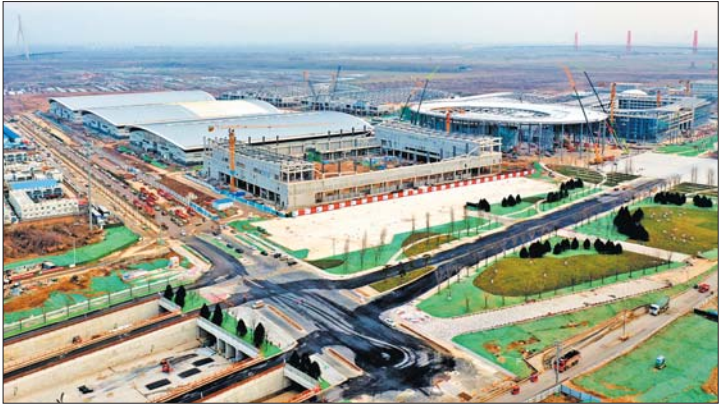
建设中的黄河大道（一期）及济南黄河国际会展中心项目，该段地道结构建设将最宽达到92m，是目前国内最大宽度地下地道结构。
