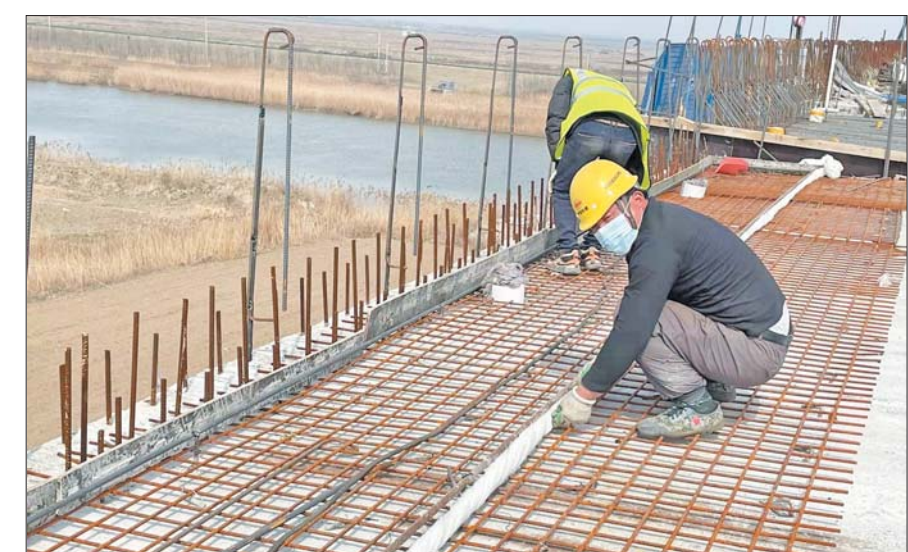
侯辛桥施工现场，工人们正在进行护栏和桥面的铺装工作。
