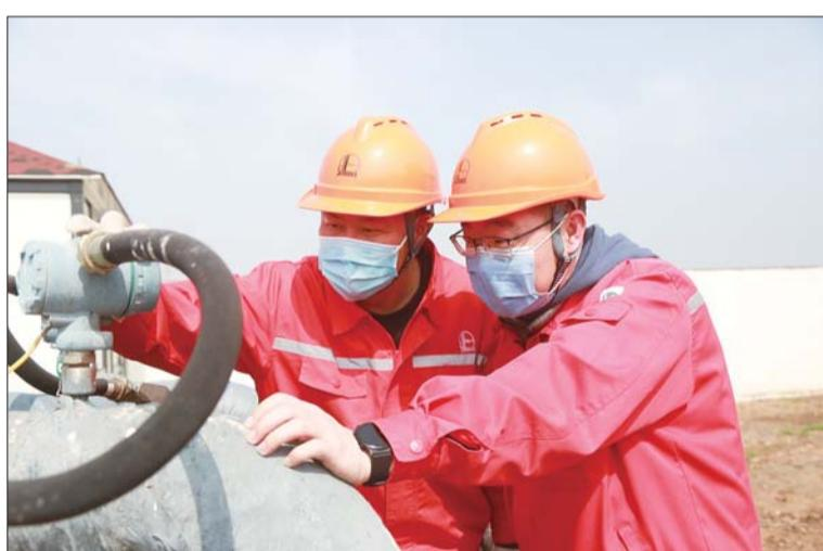
近日,在胜利油田鲁明公司济北采油管理区夏24-斜3井组机现场,工作人员正在进行抽油机游梁螺丝紧固工作。据了解,为确保雨季生产安全,济北采油管理区对所辖380余口抽油井进行详细摸排,对基础下沉及有可能下沉的抽油机进行统计,利用作业、电检等有利时机,对这些抽油机进行重组,从根本上杜绝雨季生产的安全隐患。
