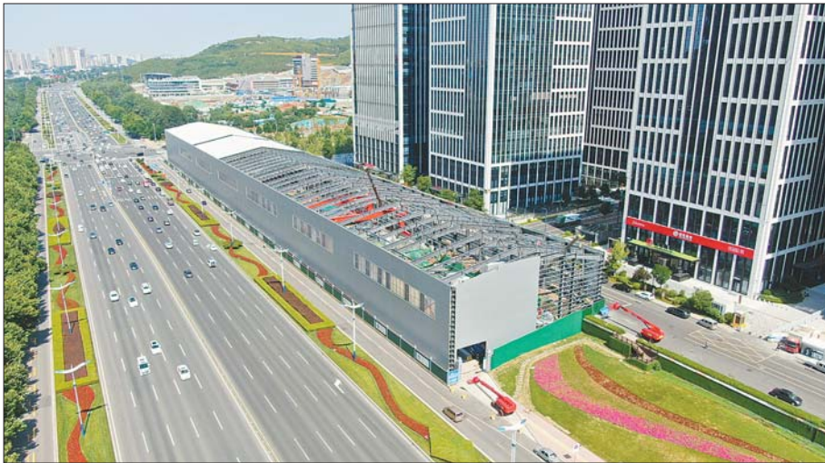
为了让周围居民不受施工噪声和扬尘的影响,济南轨道交通集团创新推出施工罩棚,把污染隔离到封闭空间。 记者 王鑫 摄
