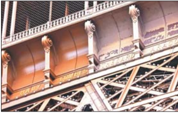
埃菲尔铁塔上的锈迹和修复好的部分
