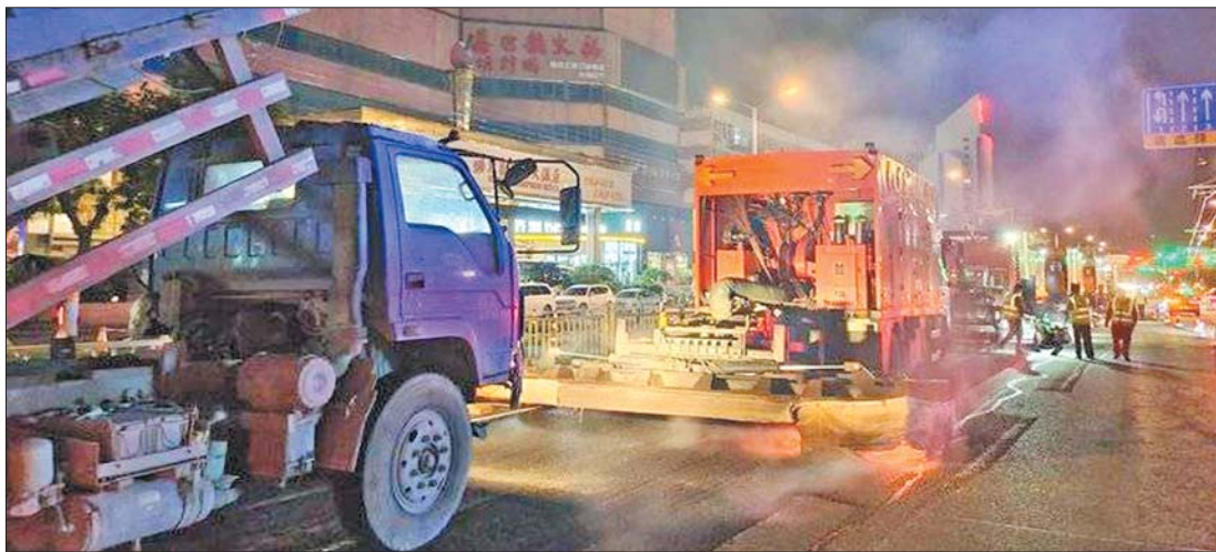
14日深夜，济南泺源大街正在修补路面，一片忙碌景象。
