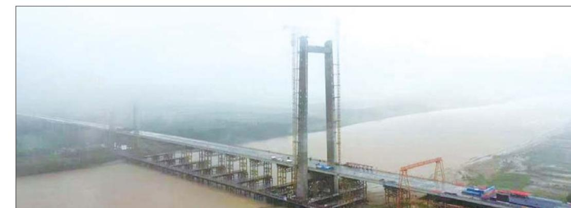
年实现合龙,顺利结束主体施工,为全国首创带桥面板全断面顶推施工画上了完美句号,为沾临高速实现年底提前通车奠定了坚实的基础。
